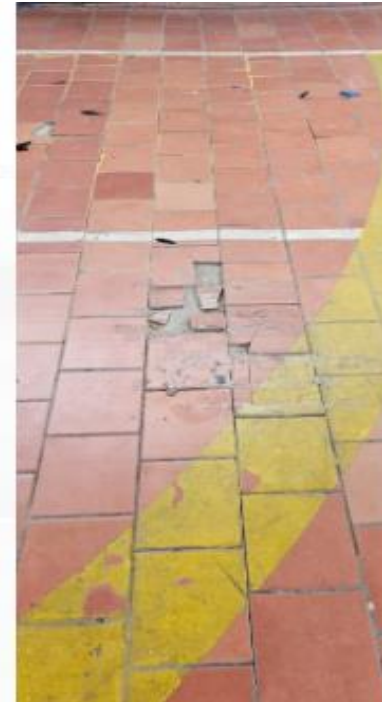
RETIRO E INSTALACION DE 6 MTS TABLETA ROJA
