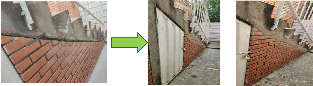
REFORZAMIENTO Y ANCLAJE EN MURO DE ESCALERA
